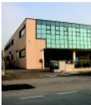
Capannone, Padova, Via Svizzera
