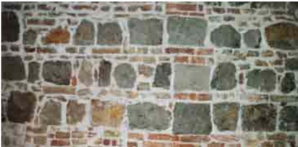
Particolare delle mura medievali all'interno della Casa vicariale
