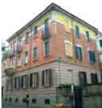
Casa di via XX Settembre
