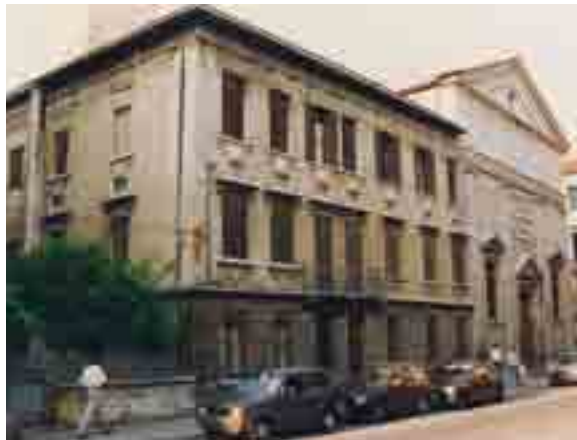
Facciata su via San Fermo prima dell'intervento
