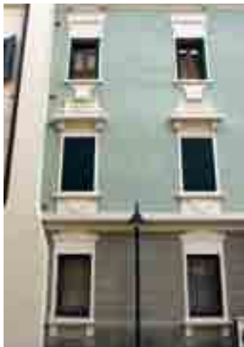
Particolare della facciata della casa vicariale
