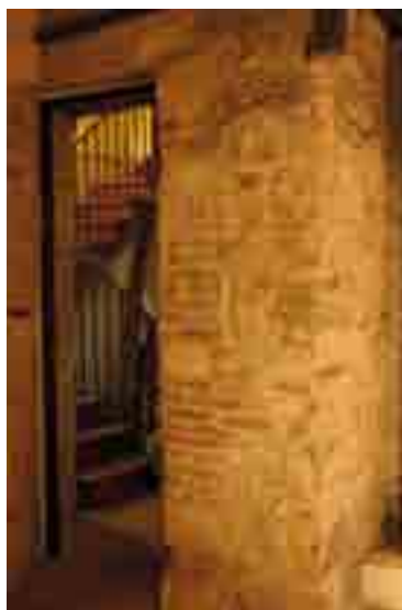
L'ingresso del campanile, prima e dopo l'intervento
